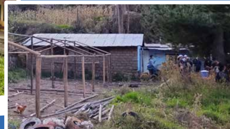
Construction d'une serre par des étudiantes et étudiants de Sciences de la nature et de Sciences humaines du campus des Îles, au Pérou.
